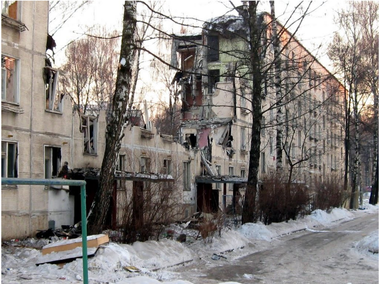
Appartementsgebouwen worden afgebroken. (Foto: Image: Vas_Nick via Panoramio)
